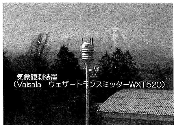
図2. 岩手大学教育学部2号館屋上に設置例
